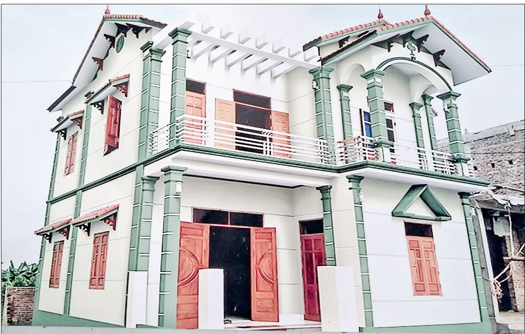
Ngôi nhà mới của vợ chồng anh Thuật chị Nhuận đang trong quá trình hoàn thiện.
