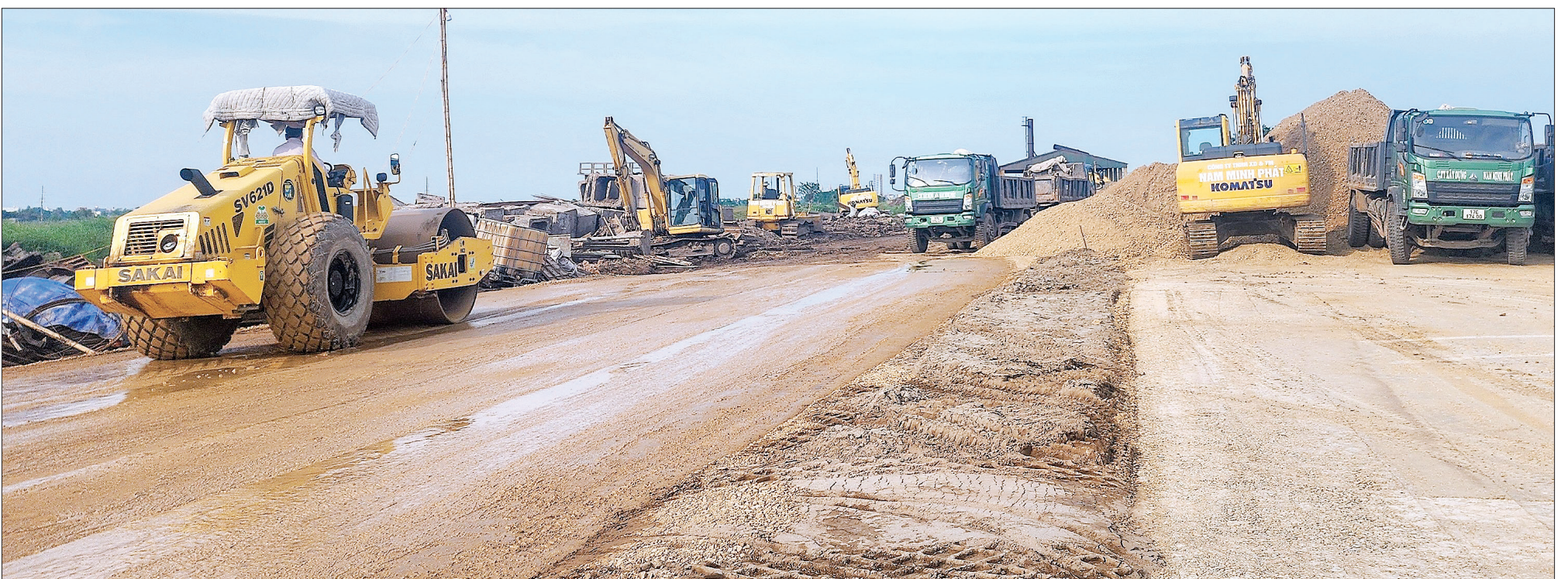
Đẩy nhanh thi công tuyến đường vào cụm công nghiệp Ninh An.
