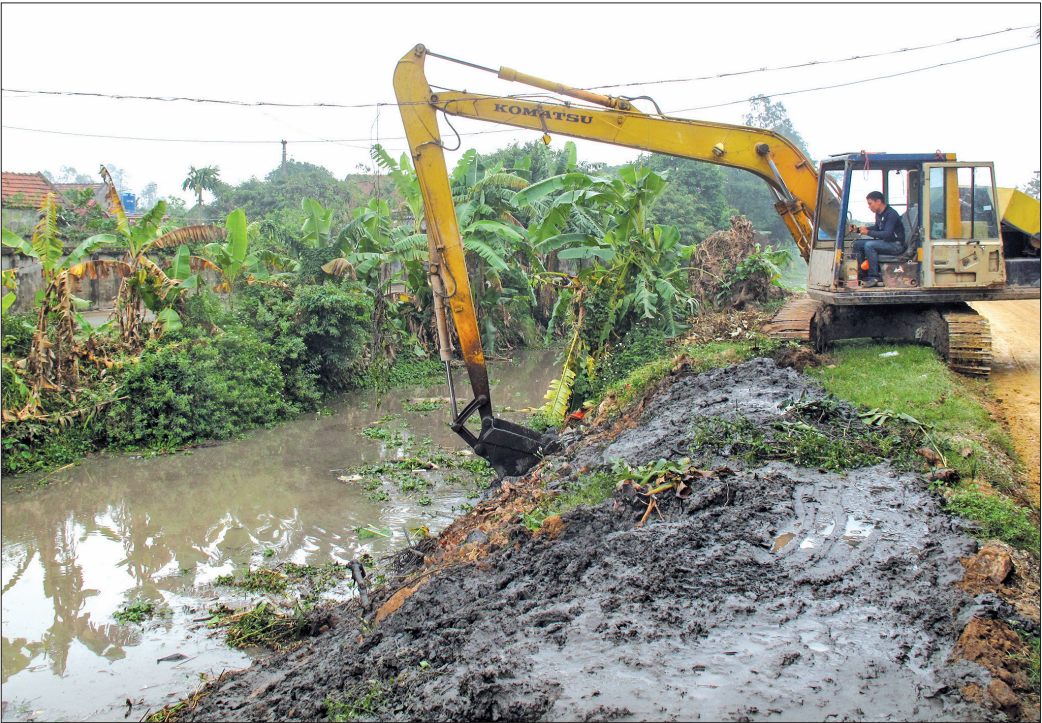
Nạo vét sông Thiên Kiều, đoạn qua địa bàn xã Thái Học (Thái Thụy).
