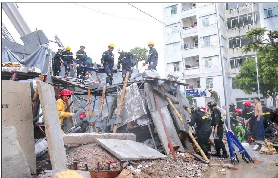
Các lực lượng tham gia tổng duyệt diễn tập phương án xử trí tình huống sập đổ công trình.
