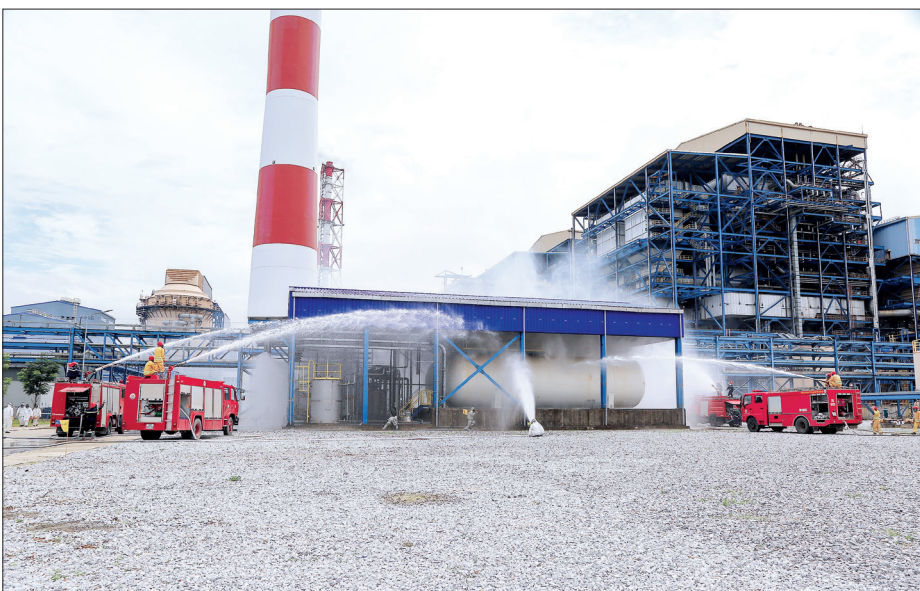
Các lực lượng tham gia tổng duyệt diễn tập tại Nhà máy nhiệt điện Thái Bình 2.
