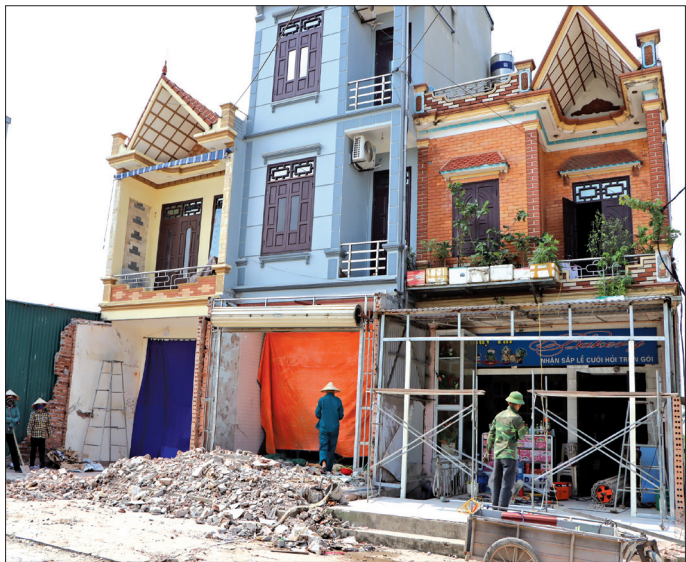
Các hộ dân xã Bình Định (Kiến Xương) đồng loạt tự nguyện phá dỡ công trình lấn chiếm trước đây.
