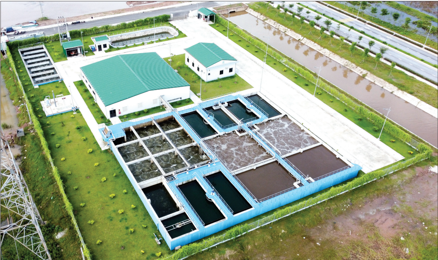
Nhà máy xử lý nước thải tập trung của khu công nghiệp Liên Hà Thái có công nghệ hiện đại, góp phần bảo vệ môi trường khu công nghiệp và các vùng phụ cận.
