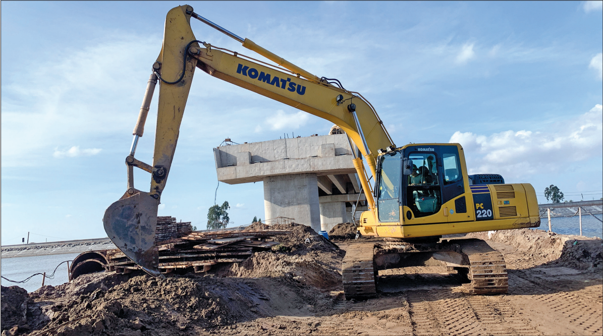
Tuyến đường bộ ven biển đang được đẩy nhanh tiến độ thi công.
