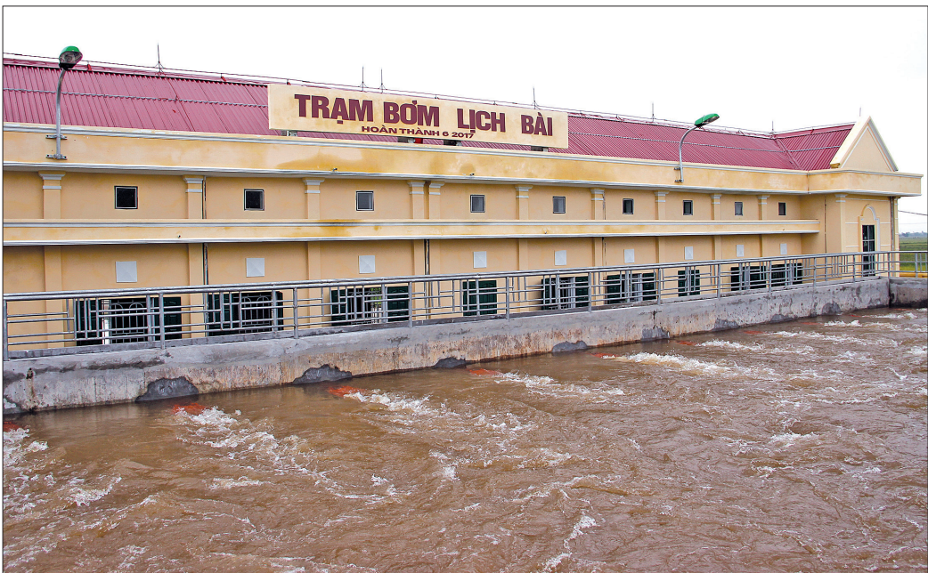
Hai công ty khai thác công trình thủy lợi Bắc và Nam Thái Bình sẵn sàng phương án điều tiết nước hợp lý, cung cấp đủ nguồn nước cho công tác đổ ải làm đất gieo cấy lúa xuân.
