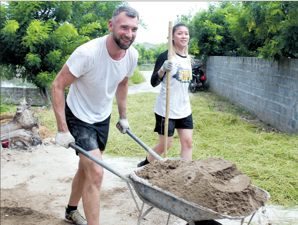
Tình nguyện viên tổ chức Habitat for Humanity giúp hộ nghèo xã Quỳnh Bảo (Quỳnh Phụ) xây dựng nhà mới.
