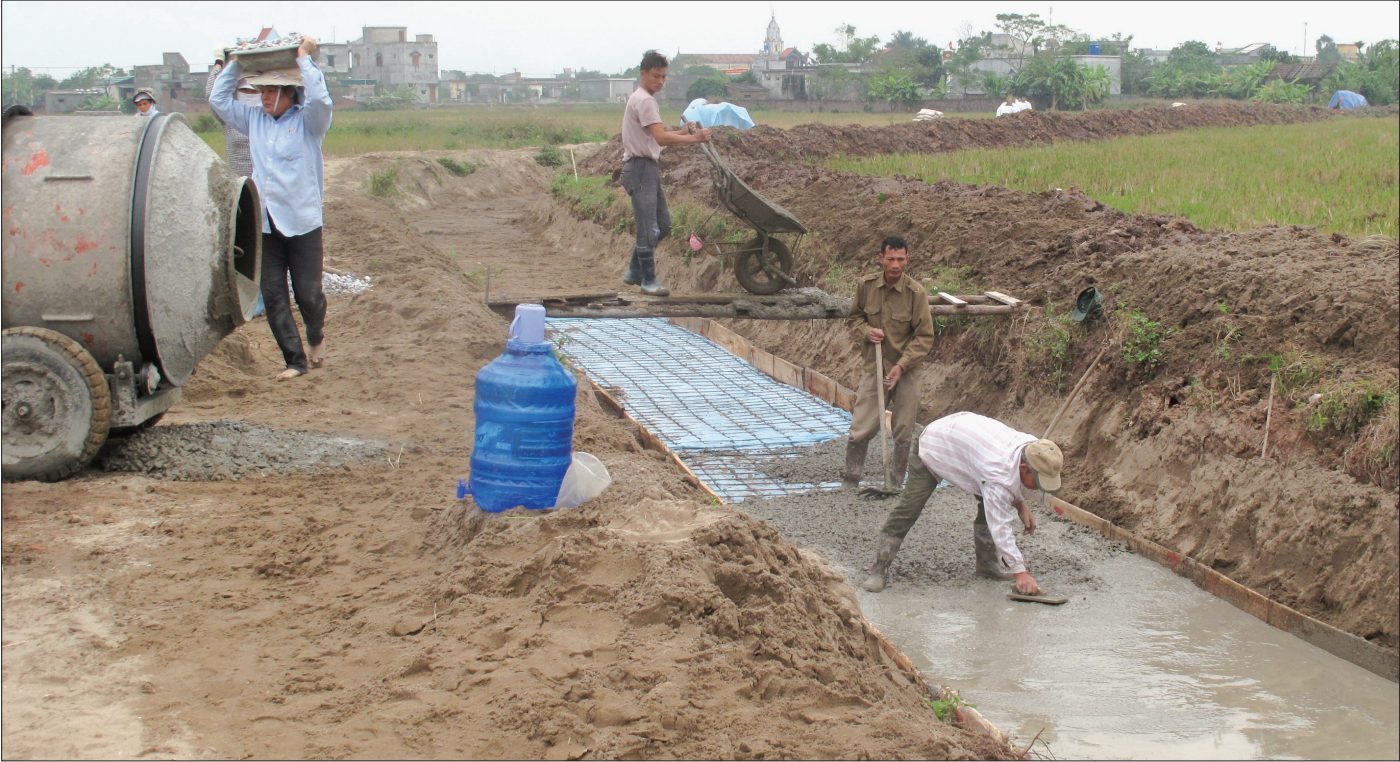
Các vùng sản xuất lúa hàng hóa trên địa bàn huyện Tiên Hải đều được đầu tư xây dựng hệ thống kênh mương tưới, tiêu đồng bộ.
