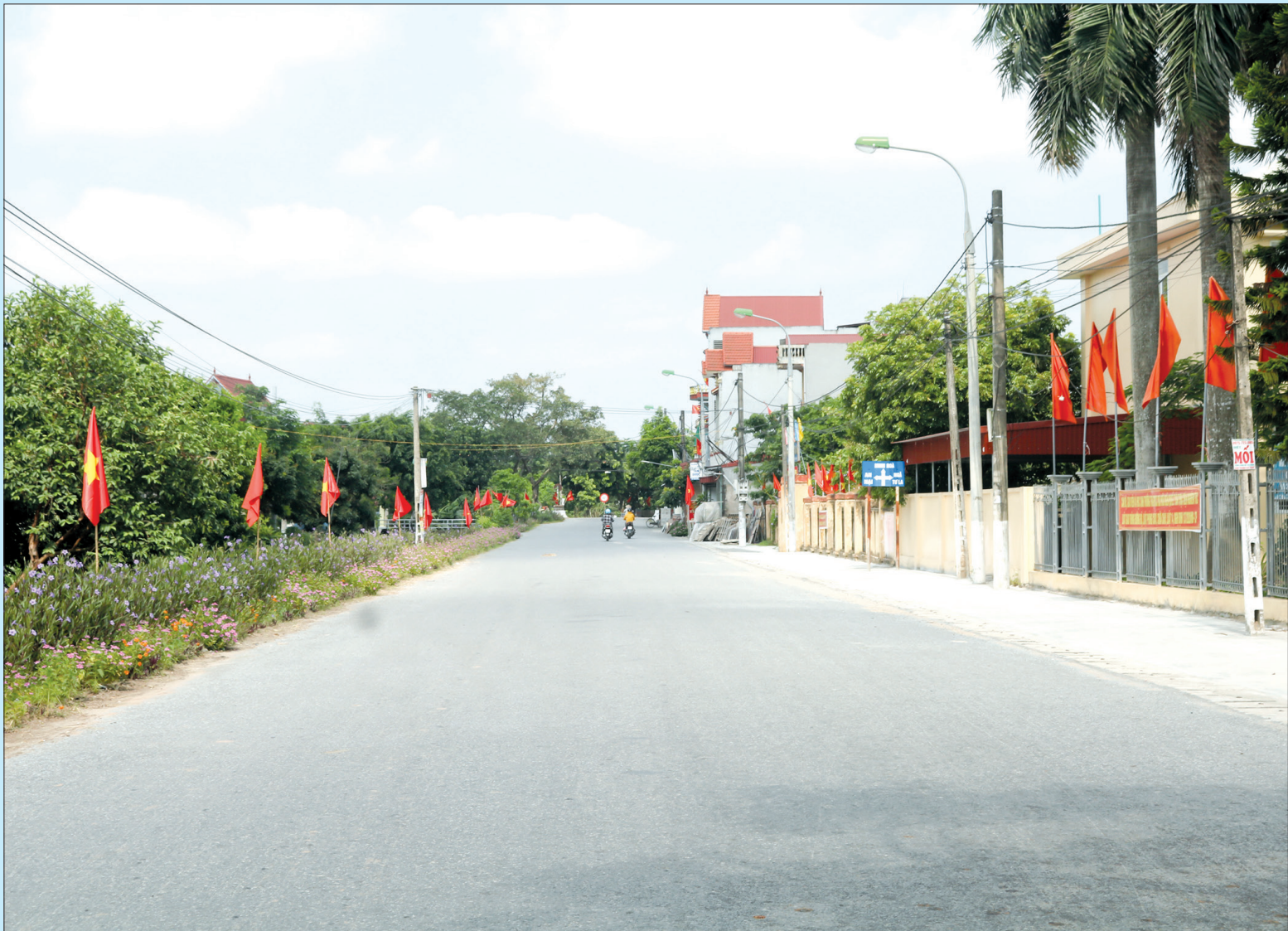
Hệ thống đường giao thông xã Chi Hòa (Hưng Hà) được đầu tư nâng cấp đáp ứng nhu cầu đi lại của người dân.
