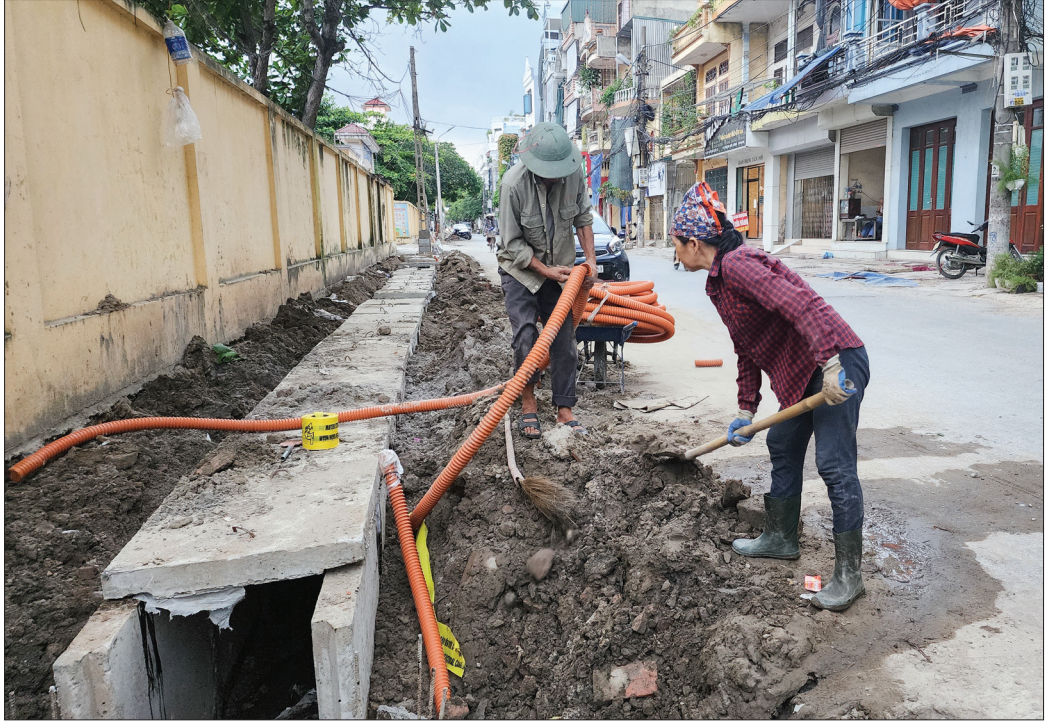
Thì công cống thoát nước tại tuyến phố Bồ Xuyên (thành phố Thái Bình).
