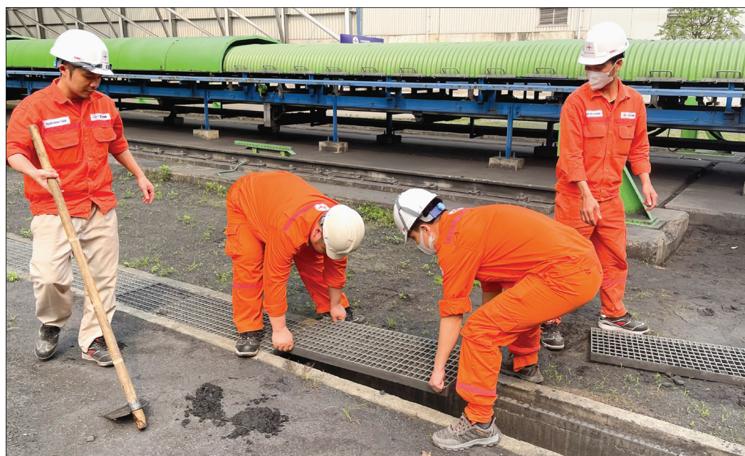
Lực lượng xung kích Công ty Nhiệt điện Thái Bình khơi thông hệ thống rãnh thoát nước xung quanh nhà máy để phòng, chống ngập úng.
