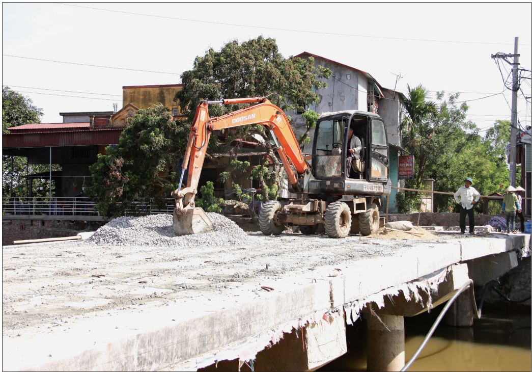
Thi công cầu Rều trên tuyến đường ĐH.47.
