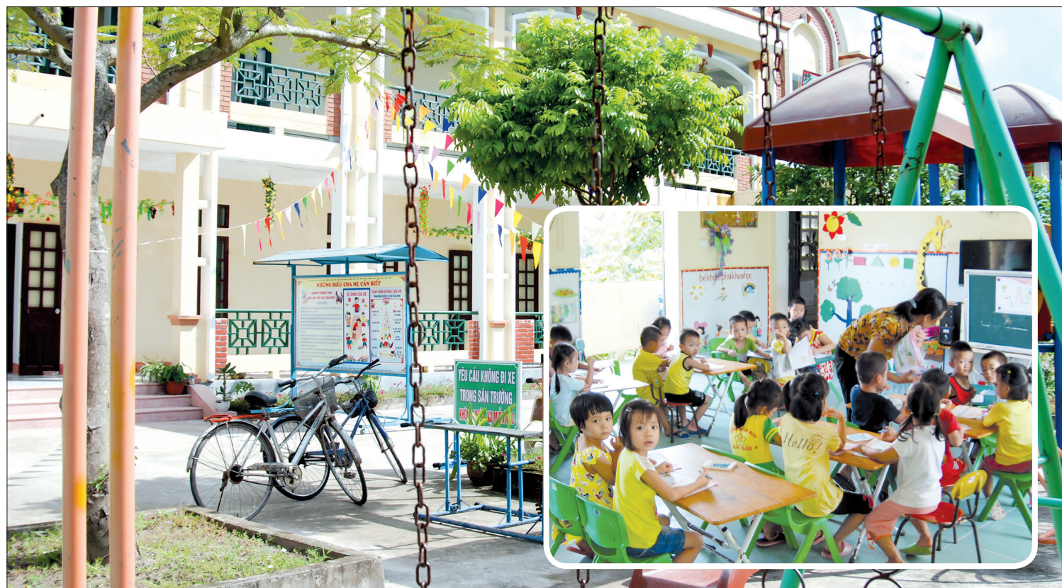
Sau 8 năm xây dựng, Trường Mầm non An Bồi mới hoàn thành.
