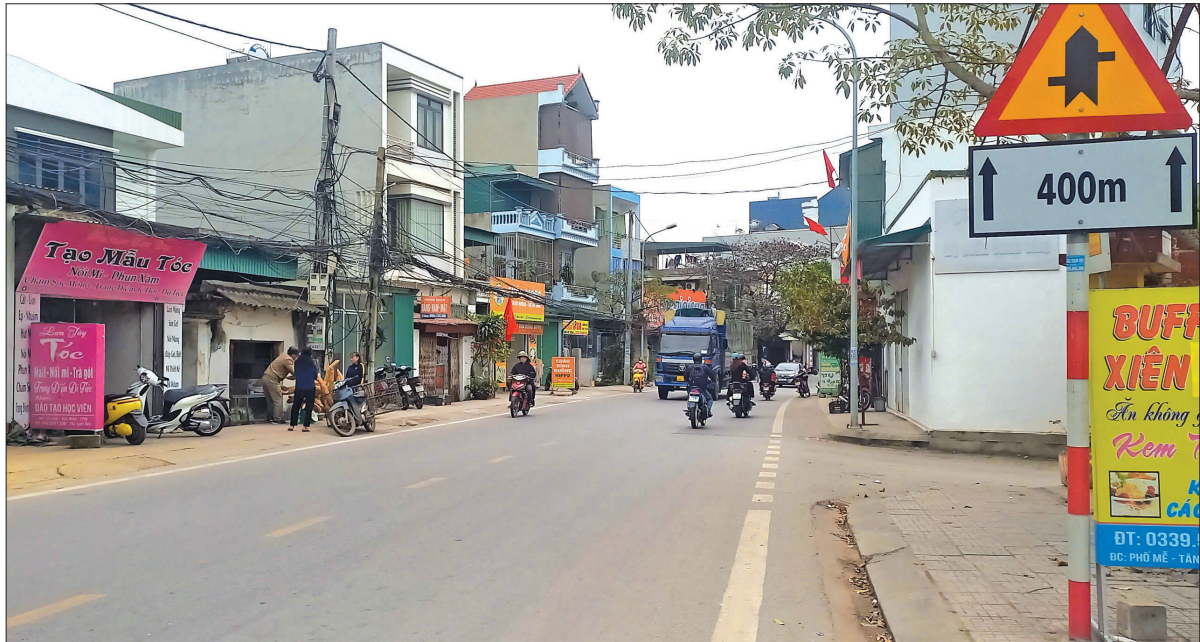
Năm 2025, các đơn vị chức năng của thành phố tiếp tục phối hợp với các doanh nghiệp tiến hành thu gom, chỉnh trang, hạ ngầm cáp viễn thông tại đường tỉnh 454 xã Tân Bình (từ ngã tư quốc lộ 10 đến giáp thôn Ô Mễ, xã Tân Phong).
