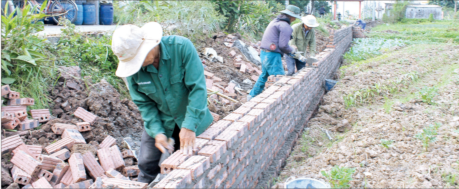
Công trình mở rộng đường trực thôn chào mừng đại hội đảng các cấp của Chi bộ thôn Đồng Đức, xã Phúc Thành (Vũ Thư).
