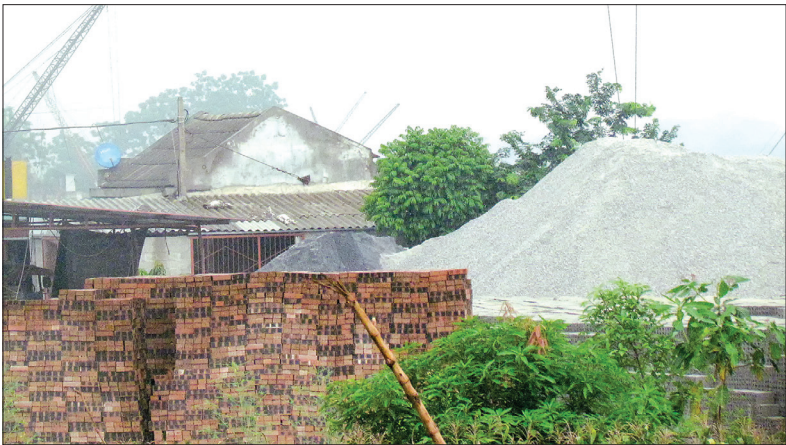
Bãi tập kết nguyên vật liệu xây dựng ngay sát chân đê gây mất an toàn mùa mưa, bão.
