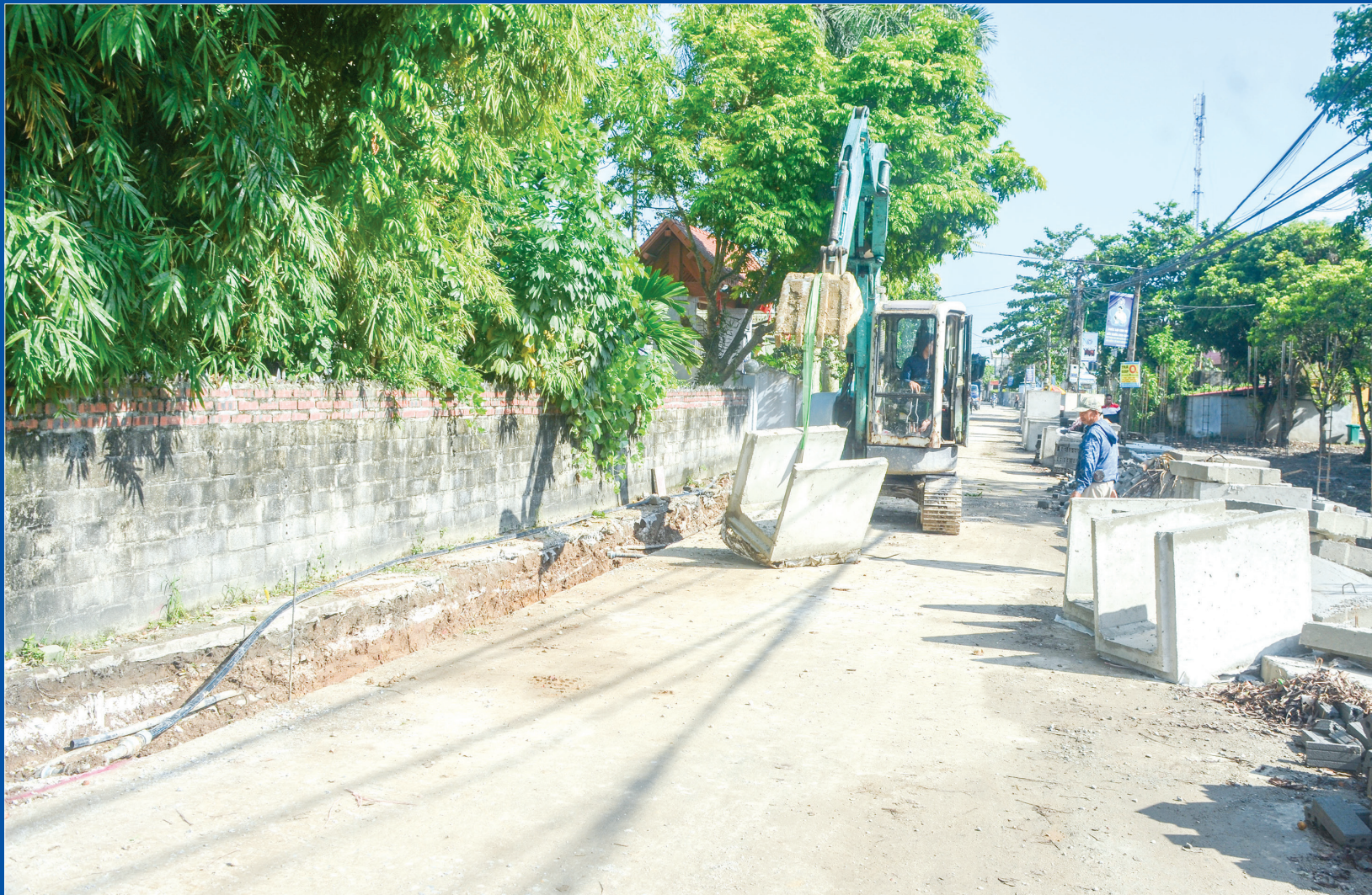
Người dân thôn Mỹ Giá, xã Quỳnh Hưng (Quỳnh Phụ) tự nguyện phá dỡ tường bao, cống dậu để thi công các tuyến đường thôn.
