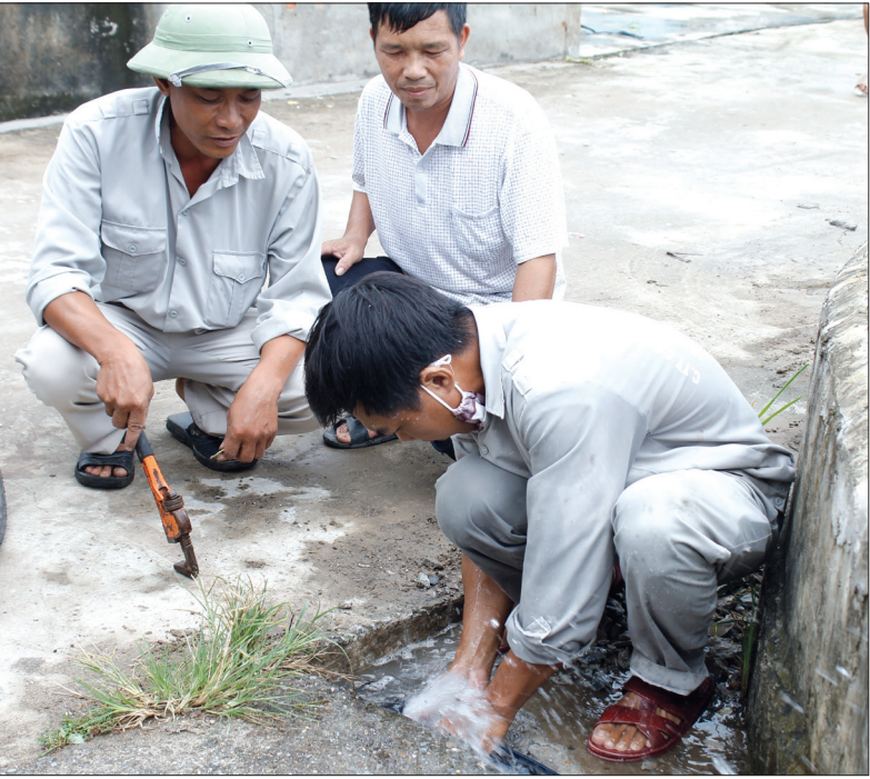
Hệ thống đường ống được khắc phục đến đâu nước về đến đó.
