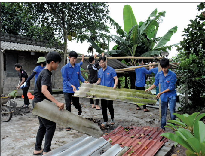
Đoàn viên, thanh niên xã Song Lãng (Vũ Thư) hỗ trợ tháo dỡ lán trại, giải phóng mặt bằng phục vụ thi công dự án đường dây 500kv mạch 3.
