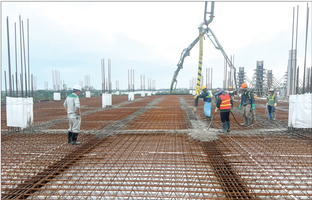
Công nhân tập trung đổ bê tông sàn tầng 1 xưởng sản xuất của nhà máy Pegavision Việt Nam.
