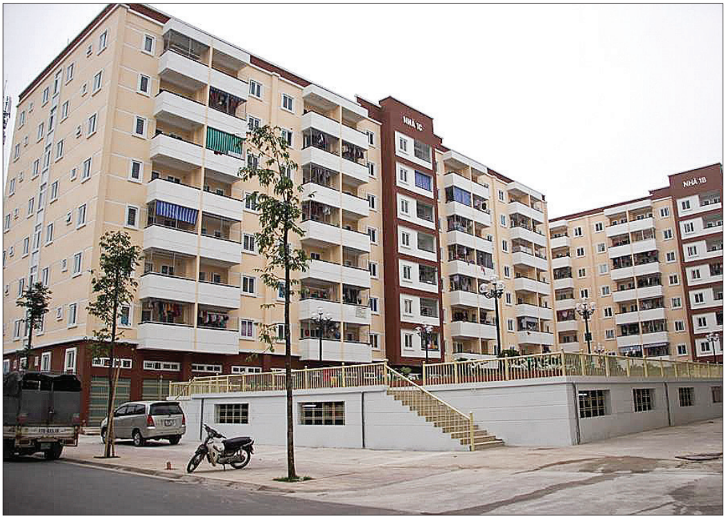
Dự án nhà ở xã hội trong khu đô thị Petro Thăng Long, thành phố Thái Bình.
