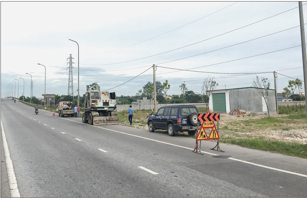
Lực lượng chức năng xử lý vi phạm hành lang an toàn giao thông trên quốc lộ 10 đoạn qua địa phận xã Đông Hòa (thành phố Thái Bình).
