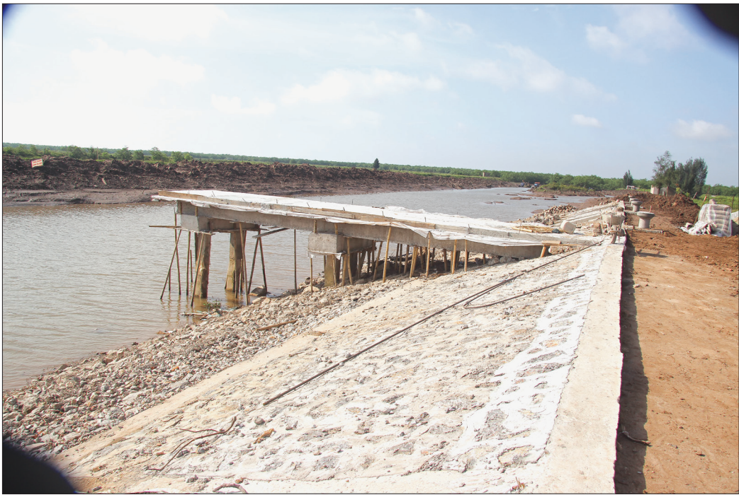
Kê cổng 7 xã Nam Phú đã hoàn thành.
