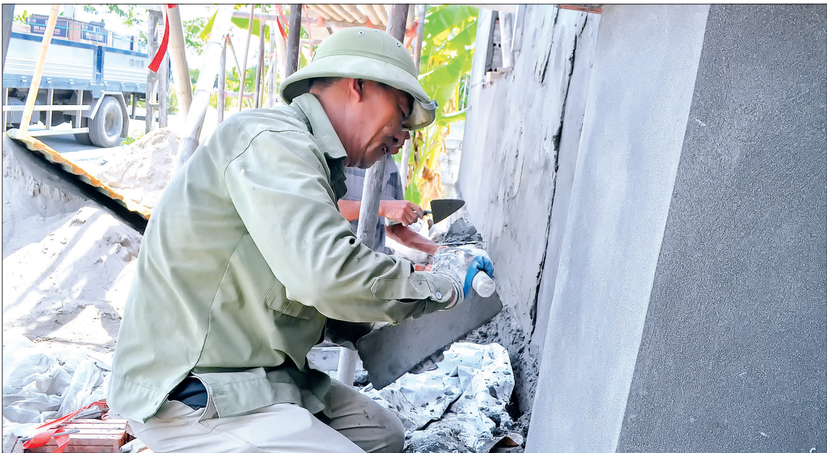
Công nhân đang gấp rút hoàn thiện ngôi nhà tình nghĩa của bà Nguyễn Thị Vạnh đúng dịp kỷ niệm 75 năm ngày Thương binh - Liệt sĩ.
