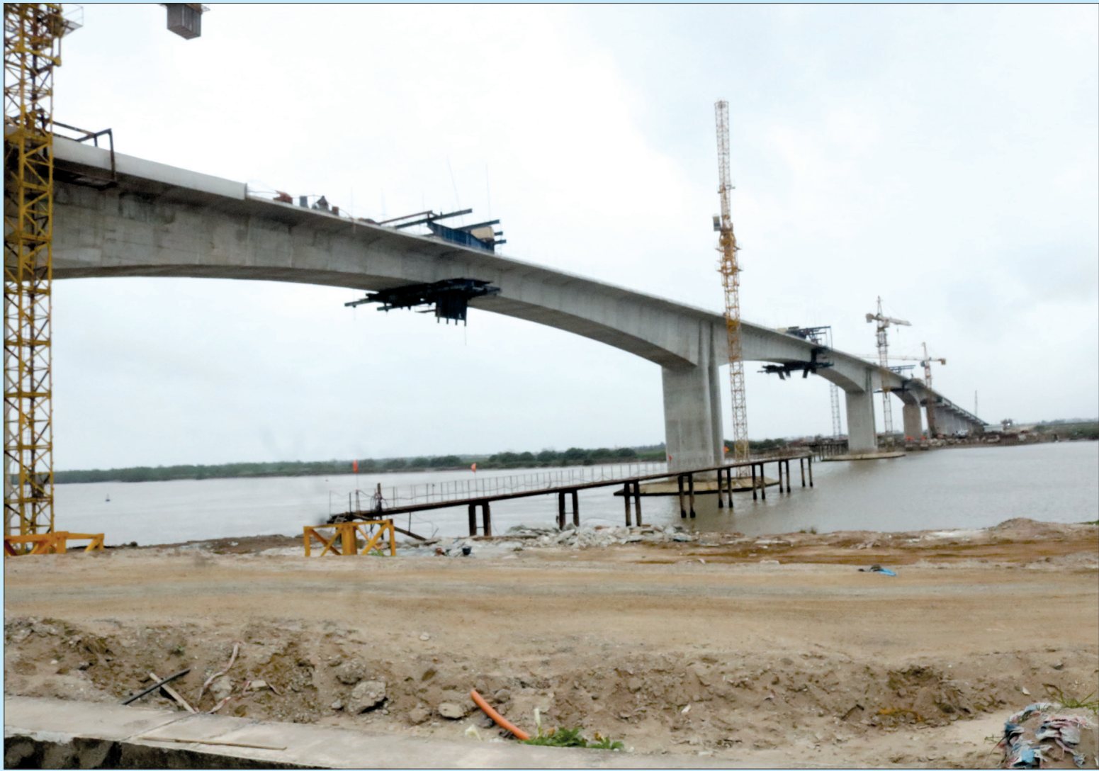
Cầu vượt sông Trà Lý trên tuyến đường bộ ven biển tỉnh Thái Bình đang được khẩn trương hoàn thiện.
