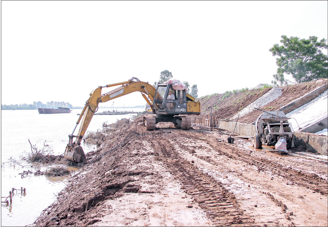
Thi công kê Vũ Đông II, từ K32+780 đến K33+080 đê hữu Trà Lý đoạn qua địa phận xã Vũ Đông, thành phố Thái Bình.
