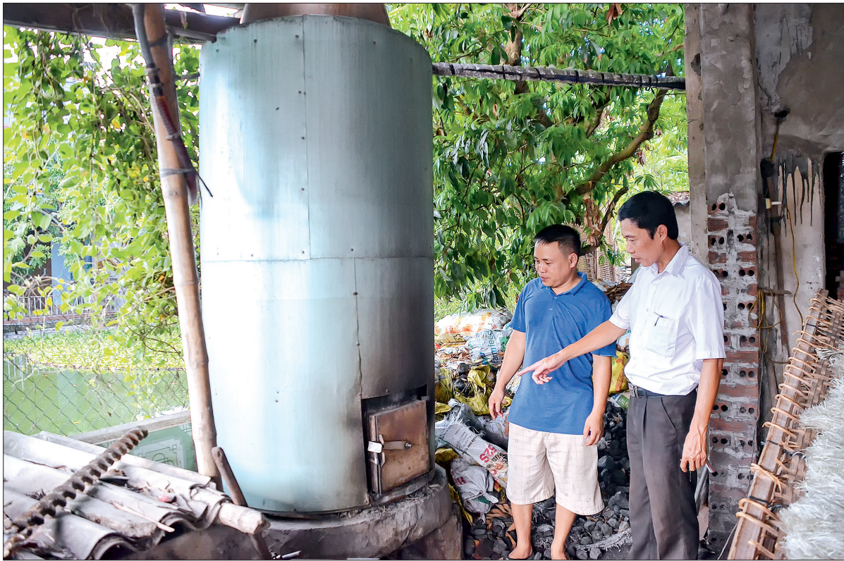
Hầu hết các hộ sử dụng nồi hơi tự chế để sản xuất, tiềm ẩn nguy cơ gây mất an toàn lao động.
