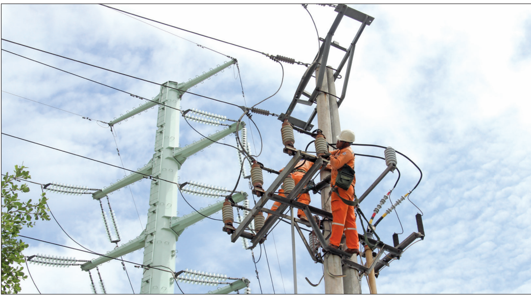
Công nhân Điện lực thành phố Thái Bình xử lý khiếm khuyết trên đường dây.
