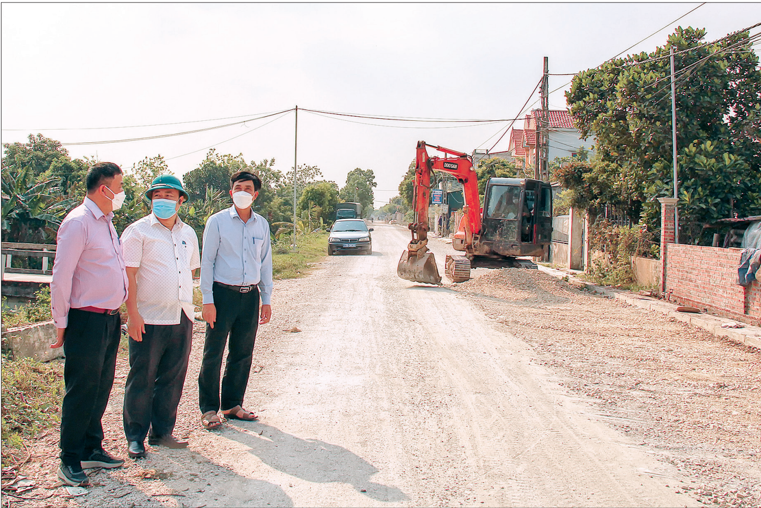
Lãnh đạo huyện Đông Hưng kiểm tra tiến độ thi công tuyến đường DH.55 qua xã Đông Xá.
