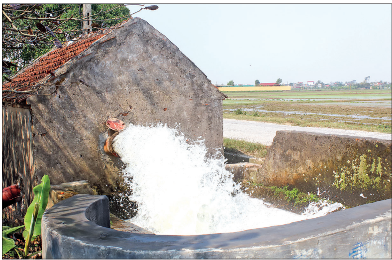
Trạm bơm xã Phú Lương (Đông Hưng) bơm nước phục vụ sản xuất vụ xuân.
