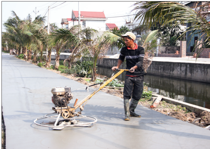
Làm đường giao thông nông thôn.
