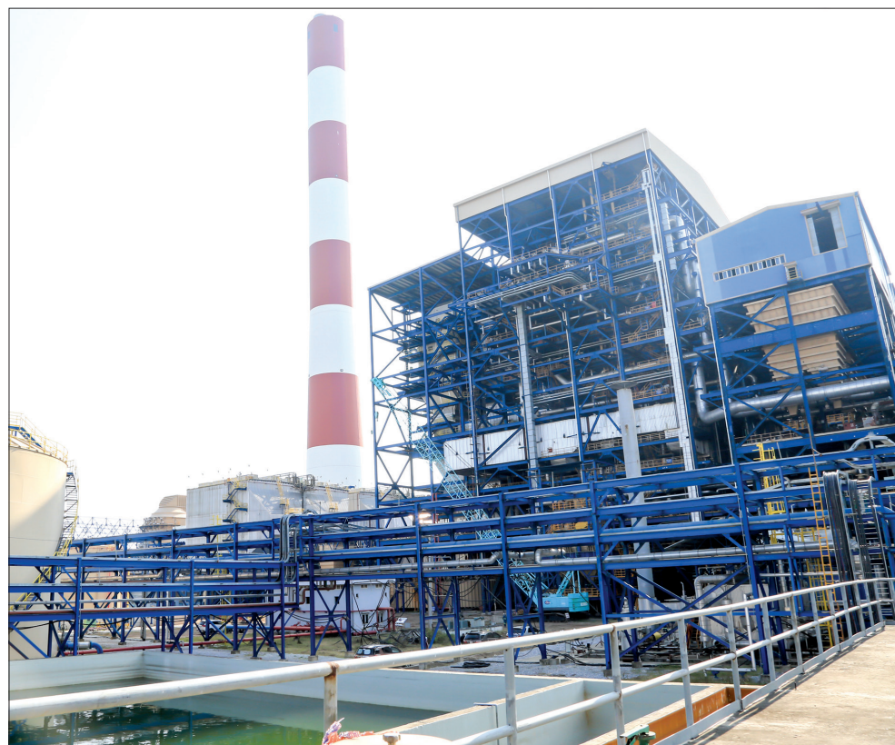
Nhà máy nhiệt điện Thái Bình 2.
