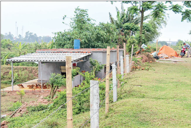
Một hộ dân vừa mới xây chuồng trại ngay sát chân đê sông Trà Lý, đoạn qua xã Thái Thọ.
