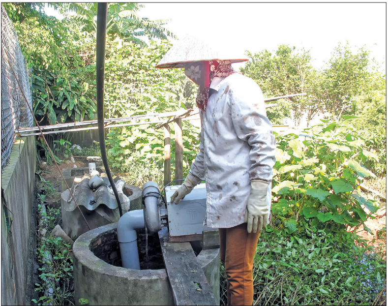
Hầm biogas tại gia đình anh Nguyễn Văn Bách, thôn Hệ, xã Thụy Ninh.
