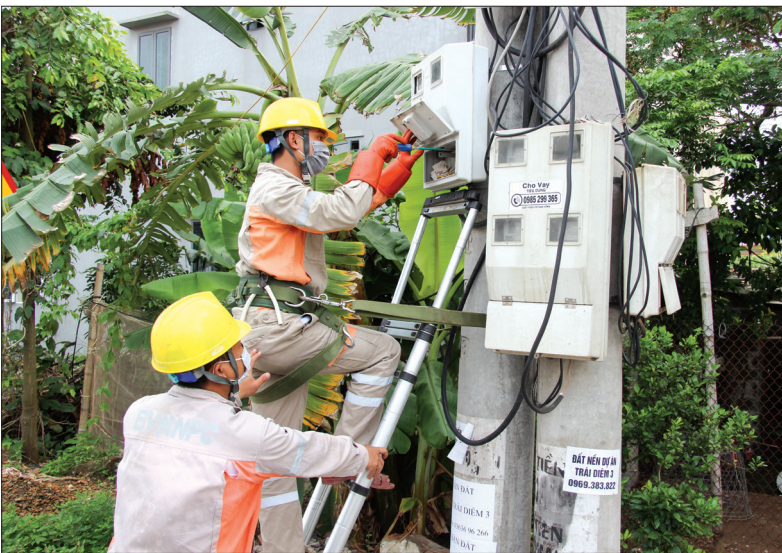
Công nhân ngành điện lắp công tơ điện tử do xa.
